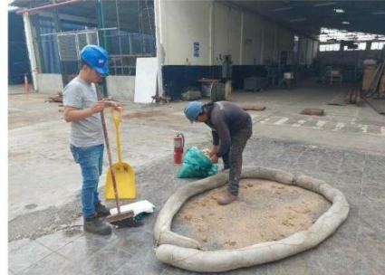
Figura 7-2 Detención del derrame y Riego de material absorbente ecológico
