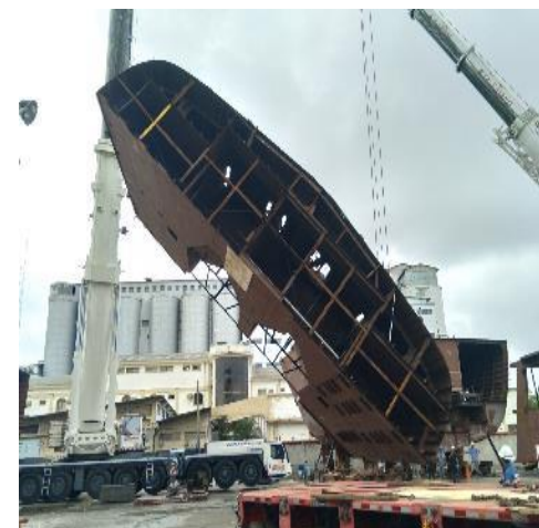
4. Volteo de las secciones U28.1+U28.2.
